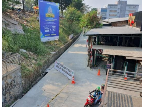
Gambar 3. Jalan lingkungan yang dicor (Sumber: Flickr ).
